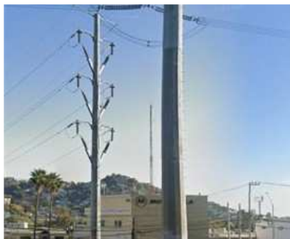
Figura 5. Condición urbana en la que el cruce con una línea de transmisión de 400 kV impide la continuidad aérea de la línea de 115 kV.
