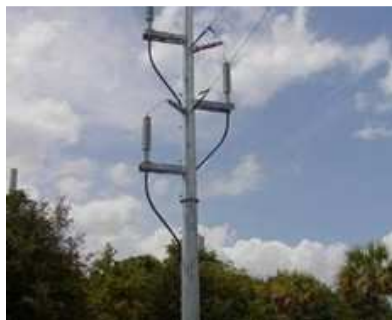
Figura 4. Configuración convencional de transición aéreo-subterránea, con los cables de potencia instalados exteriormente sobre la estructura.
